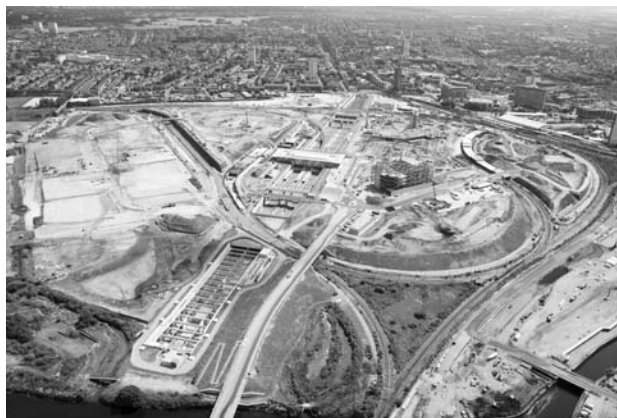
ストラトフォード五輪の選手村向けに大規模な建設が進められている。五輪終了後、広大な敷地に転用される公園や住宅予定
