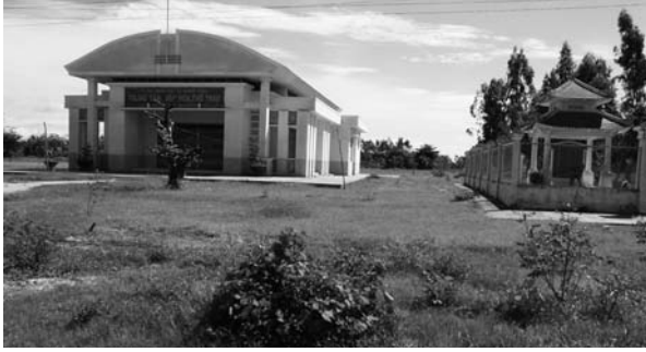
集住区につくられた公共建築物。集住区は運河に沿って細長く造成され、区画された側溝と道路が交差する。雑草が茂る平地に、ぼつん、ぼつんと公共建築物が建つ
